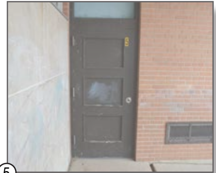
⑤ WOOD DOOR & HOLLOW METAL FRAME
